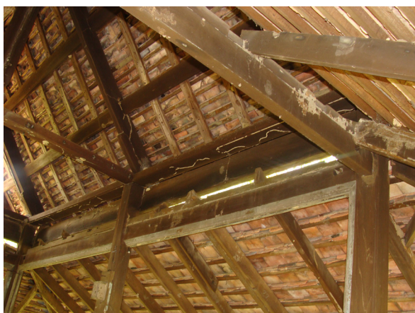
Foto 2: Serangan anai-anai pada kerangka bumbung Sumber: Projek Baikpulih Rumah Penghulu Natar, Merlimau, Melaka, 2009
