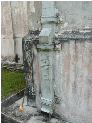
Foto 16: Saluran paip air tidak sempurna, corong air di atas lantai menyebabkan air tidak dapat disalurkan dengan baik.
