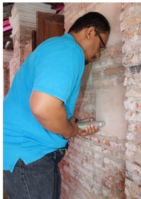
Foto 9: Membuat ujian lepaan ke atas beberapa sampel mortar menggunakan Hammer Rebound
