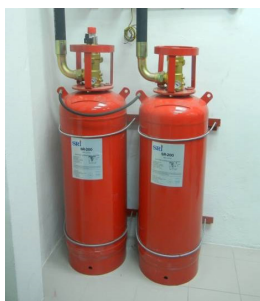
Foto 23: Pemasangan Sistem Pencegahan Kebakaran Serbuk Kering Sumber: Bahagian Konservasi, 2015
