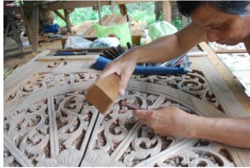
Foto 19: Mengukir kerawang tingkap. Sumber: Projek Pemuliharaan Masjid Lama Kampung Kuala Dal, Perak, 2009
