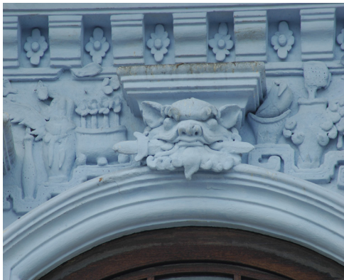
Foto 17: Lepaan bercorak atau plasterworks pada permukaan dinding Rumah Kedai Kampung Cina, Melaka
