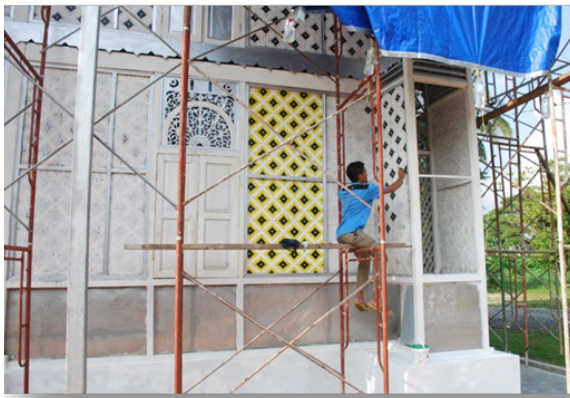
Foto 20: Kerja-kerja mengecat kelalai dinding Sumber: Projek Pemuliharaan Masjid Ihsaniah Iskandariah, 2015
