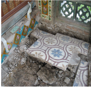
Foto 13: Kerja-kerja pemuliharaan jubin lantai yang rosak Sumber: Projek Pemuliharaan Rumah Penghulu Natar, 2009
