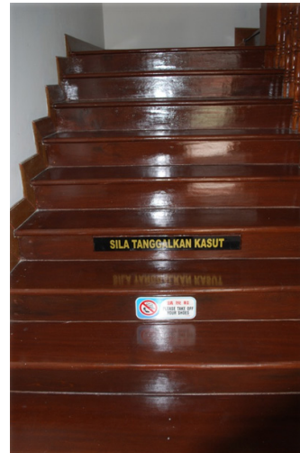
Foto 22: Tangga kayu di bangunan warisan mempunyai keunikan binaan dan kebiasaannya dari jenis kayu keras Sumber: Projek Pemuliharaan Sanitary Board, Perak, 2008
