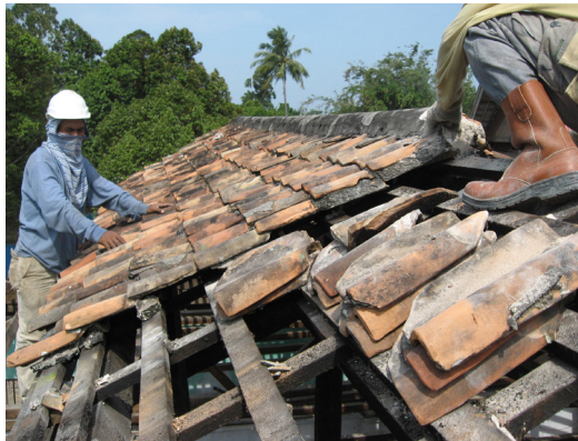
Foto 5: Membawa turun genting untuk kerja-kerja pencucian Sumber: Projek Baikpulih Rumah Penghulu Natar, Merlimau, Melaka, 2009
