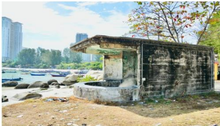
Struktur kubu kebal yang masih dalam keadaan baik.
